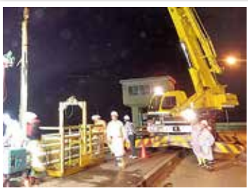
クレーンによる作業(夜間)
