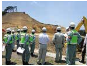
掘削面の危険個所のチェック
