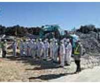
垂木川護岸工事
