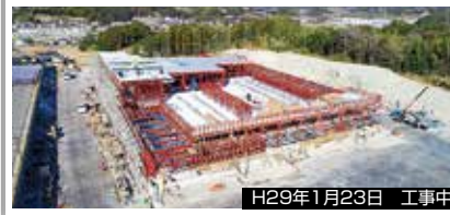
H29年1月23日 工事中
